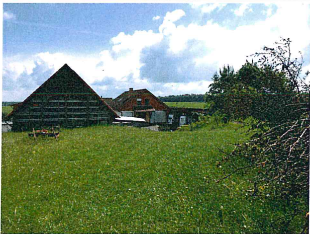
F3: Blick von Westen auf das Gebäude des Gewerbebetriebs
