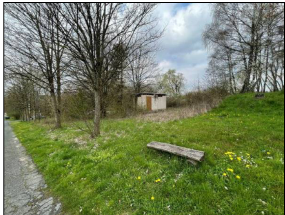
Abb. 5: Gehölzbestand mit altem Trafohäuschen Foto: M. Grenz (21.04.2023)
