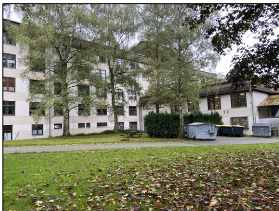
Abb. 3: Bebauung im zentralen Gebiet
