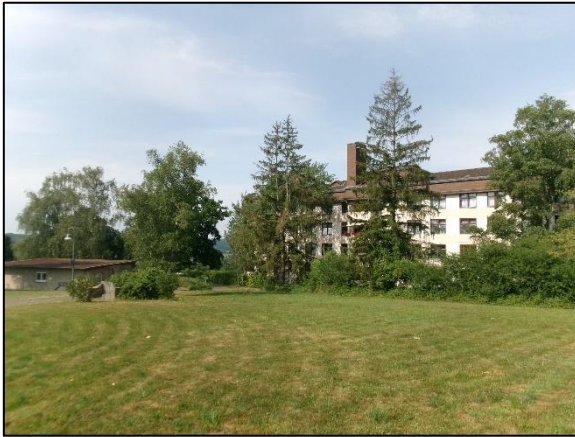
Abb. 7: Hauptgebäude und Grünflächen im Osten und Zentrum des Plangebietes.
