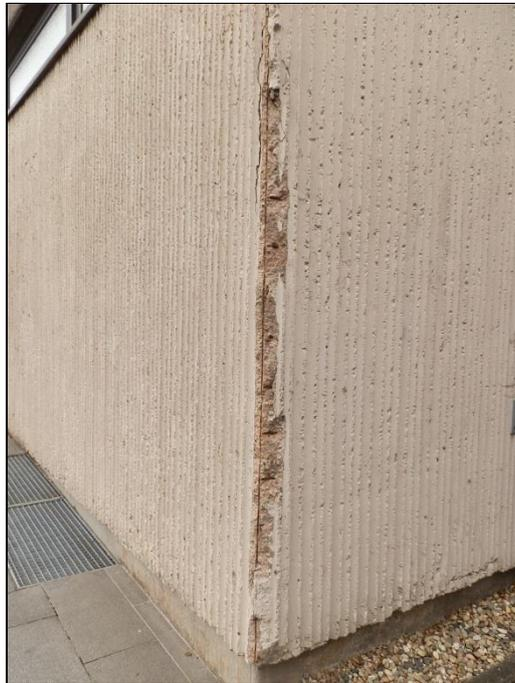
**Schäden an der Betonfassade**
