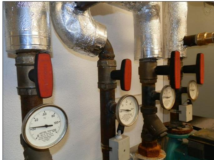
**Absperrventile ohne Dämmung**
