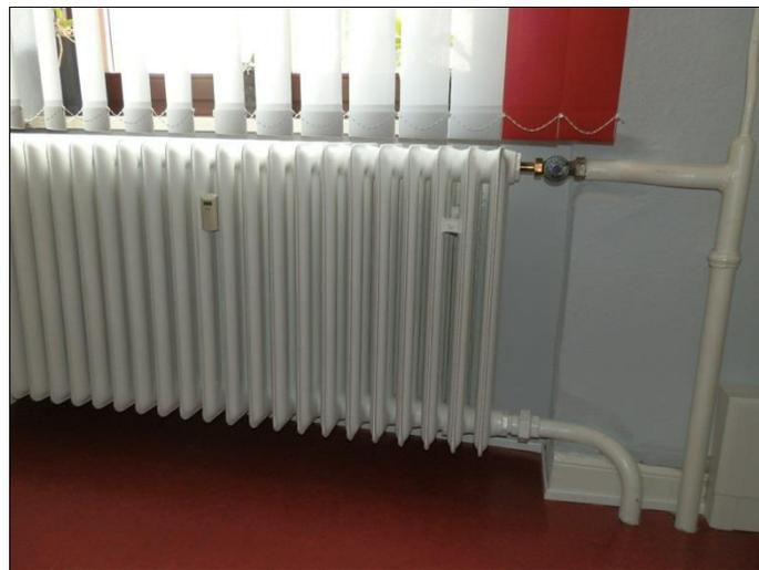
**Heizkörper mit altem Thermostatventil**
