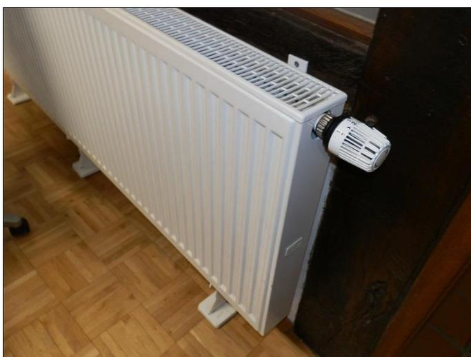
**Ventilheizkörper mit voreinstellbarem Thermostatventil**
