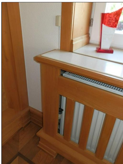
**Heizkörper hinter Holzverkleidung mit demontiertem Thermostatregler**
