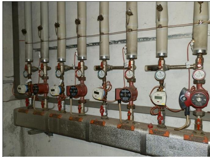
**Heizungsverteiler und Umwälzpumpen**
