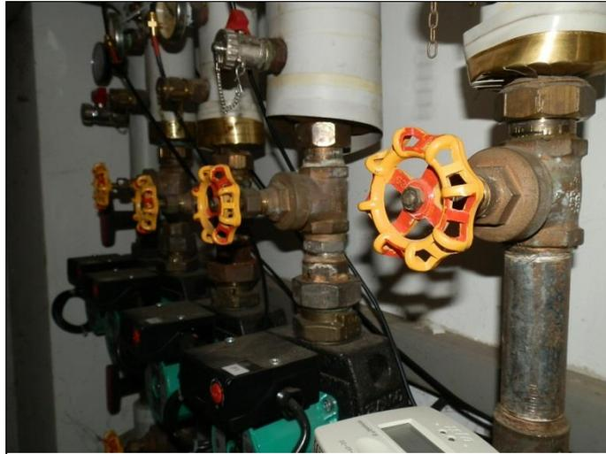
**Alte Absperrventile ohne Dämmung**
