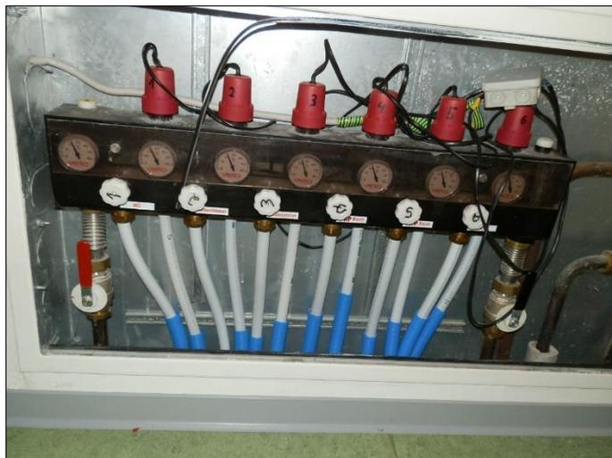
**Fußbodenheizverteiler mit elektronischen Ventilen**
