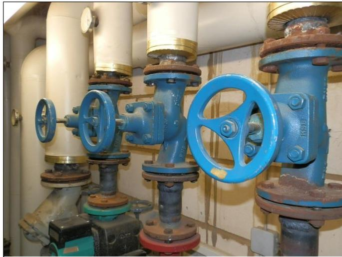
Veraltete und ungedämmte Absperrventile im Heizraum
