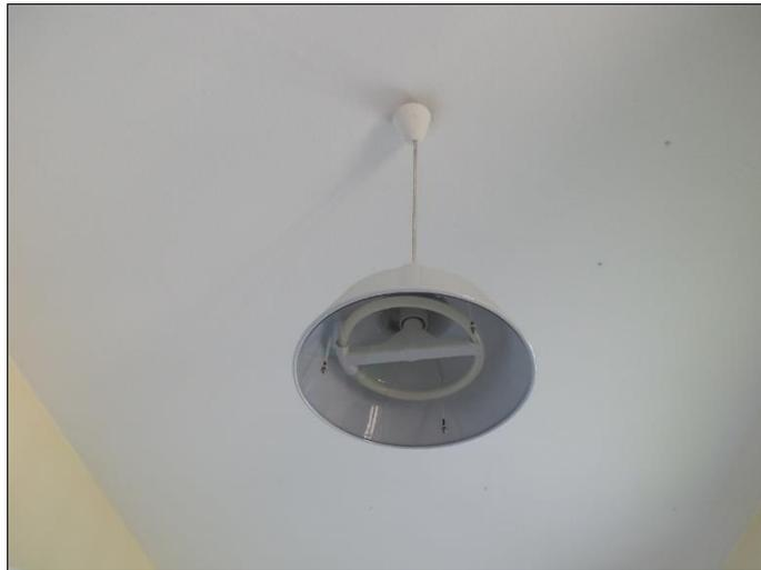
**Flur/abgehängte Leuchte mit Kompaktleuchtstofflampe**
