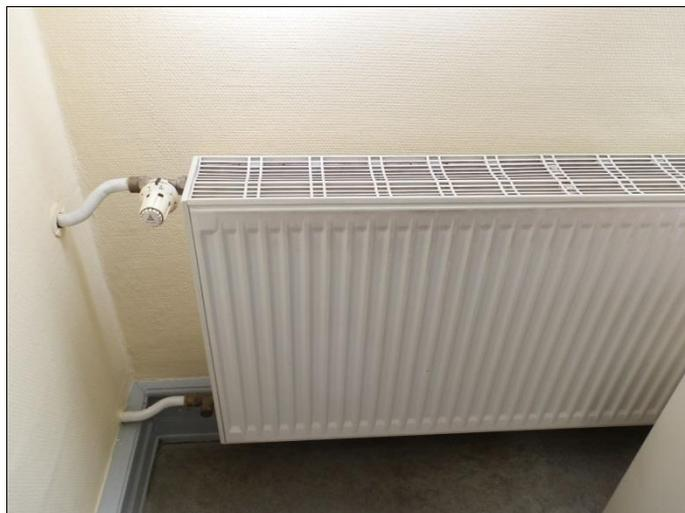
**Radiator mit Danfoss-Thermostatventil**
