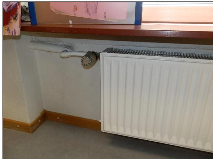
**Heizkörper mit alten Thermostatventilen**
