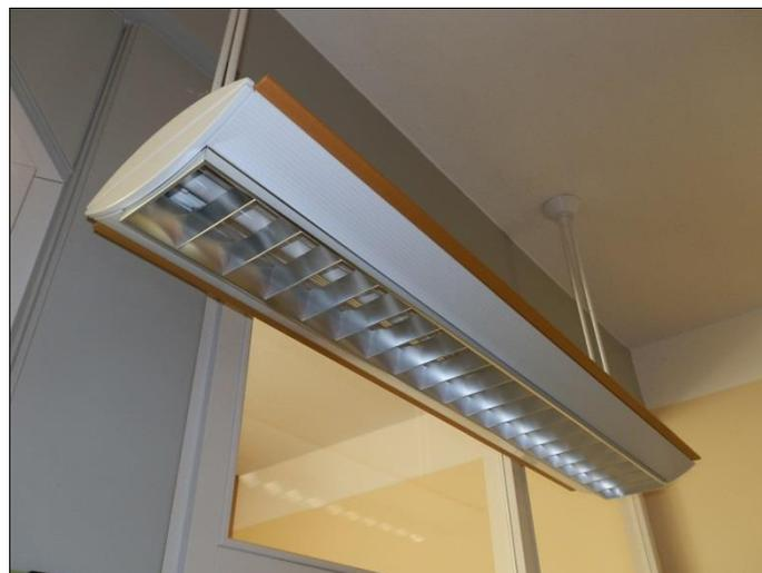
**Abgehängte Leuchte mit T8-Lampen**
