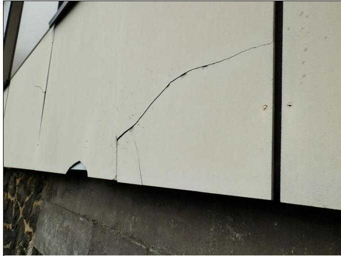
**Eternitplatten mit Rissen/Schäden an der Fassade Altbau**
