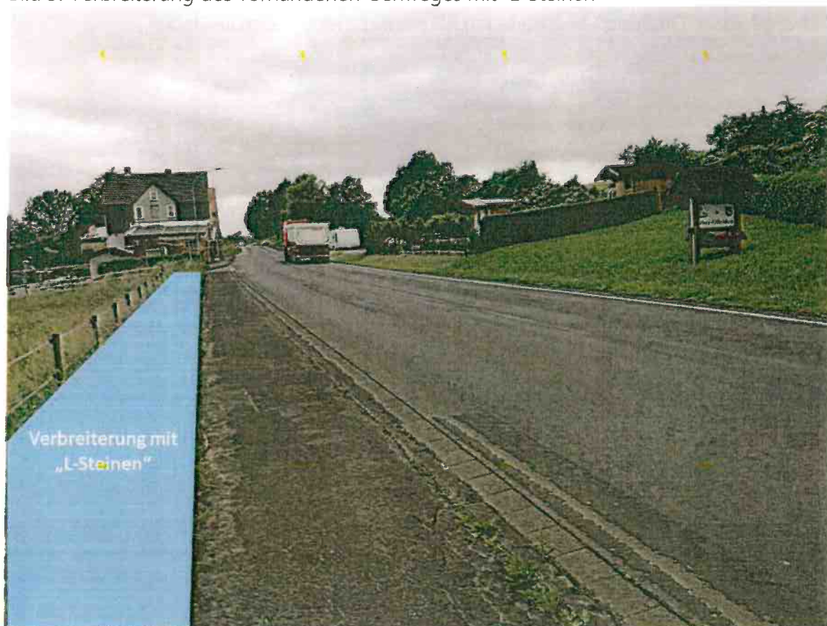
Bild 3: Verbreiterung des vorhandenen Gehweges mit "L-Steinen"
