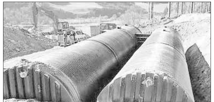
Bild: zweiteiliger Röhrenhochbehälter aus Kunststoff vergleichbar Planung Amöneburg
