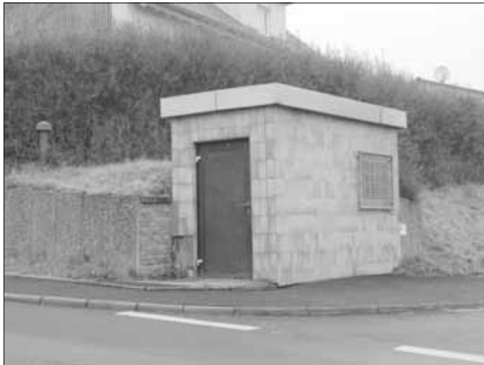
Bild: „Pumpstation Kesselgasse“ im heutigen Zustand
