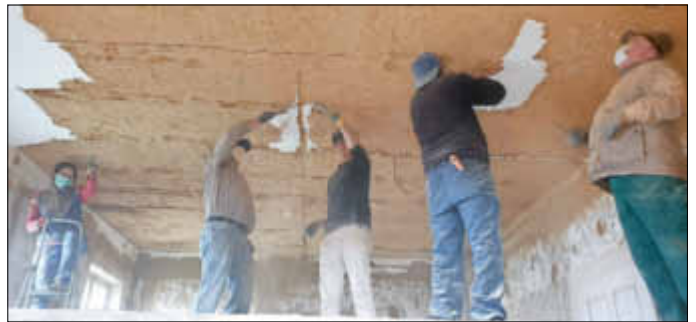
Baustelle der Ausstellungsräume im April 2019
