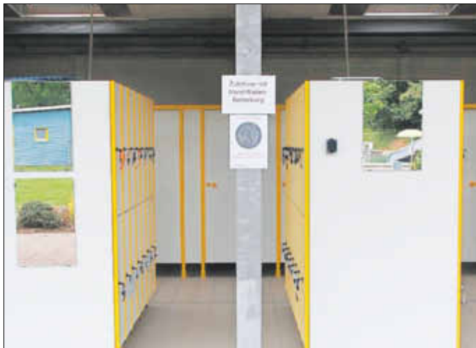
Schilder weisen an allen wichtigen Punkten im Freibad auf die nötigen Hygienemaßnahmen hin, © Bick/Stadt Homberg (Ohm)
