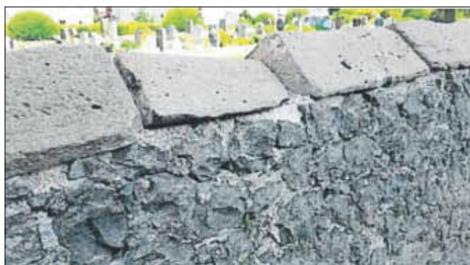
*Der tieferliegende Stein wird aufgenommen und soweit untermauert, dass er höher liegt und die Flucht der angrenzenden Abdecksteine aufnimmt.*
